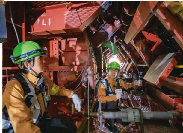
一回の発破で1m50cmぐらいずつ掘削。この作業を少しずつ繰り返してちょっとずつ前へ!
